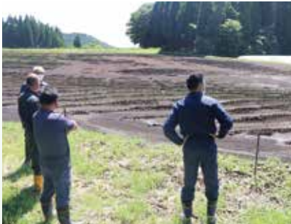
県内大雨被害の現地視察
