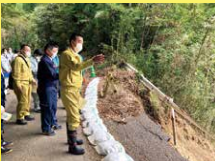
台風14号被害視察(宮崎県)
